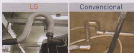
Novo sistema de drenagem
